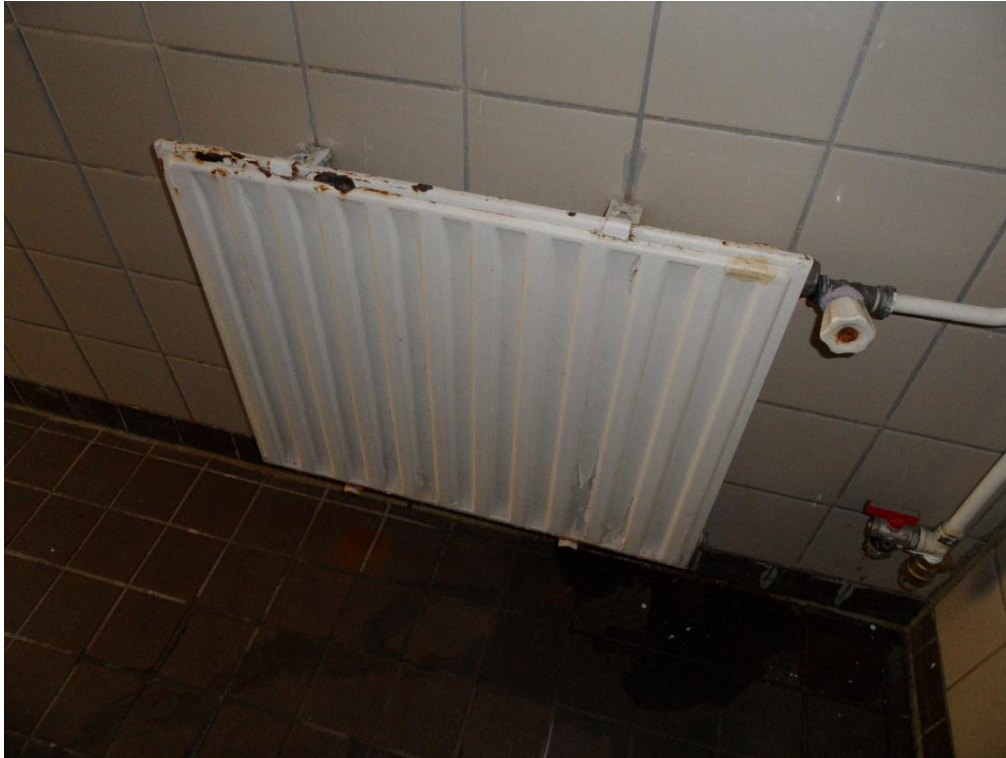
Bijlage VI, figuur 7.1: Radiator in badkamer, in zeer slechte staat. Dit is voor toekomstige huurders verre van aantrekkelijk (foto: Myles, M.)
