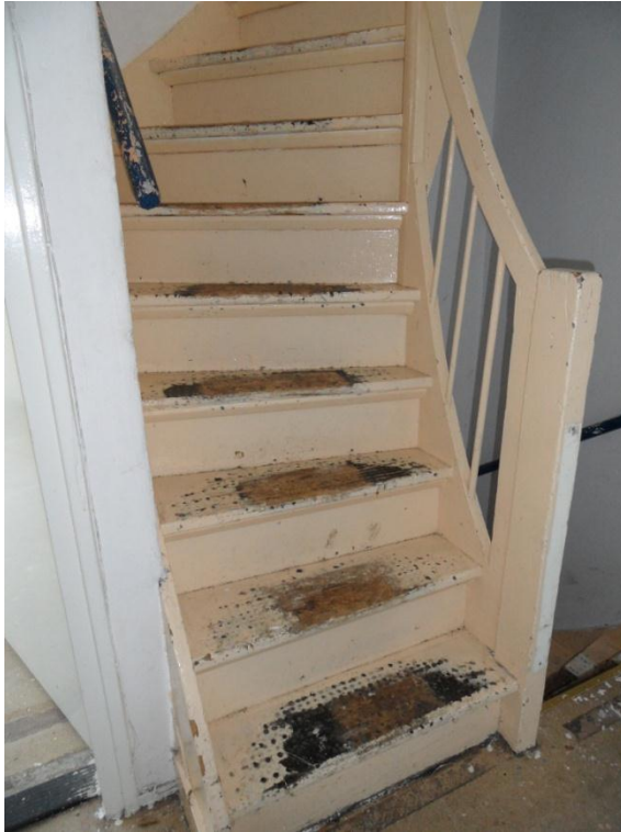
Bijlage VI, figuur 7.3: Versleten trap in een uitgeleefde woning, er ontbreekt meer dan alleen een verflaag. (foto: Myles, M.)
