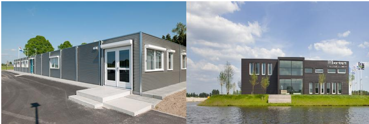
Figuur 12: Twee voorbeelden van gerealiseerd verplaatsbaar vastgoed met een bedrijfsfunctie.
